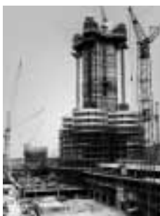
Bau des „Vierzylinders“ als Sitz der BMW Hauptverwaltung im Münchner Norden, 1970, rechts die Baugrube noch ohne die Kernkonstruktion.
