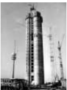
Bau des „Vierzylinders“ als Sitz der BMW Hauptverwaltung im Münchner Norden, 1970, rechts die Baugrube noch ohne die Kernkonstruktion.
